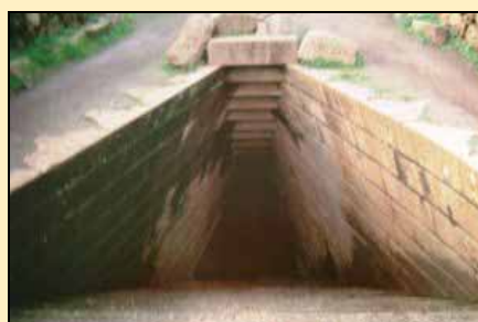
Particolare del pozzo sacro Santa Cristina – Luoghi di culto, i pozzi sacri stupiscono per la loro perfezione costruttiva.
