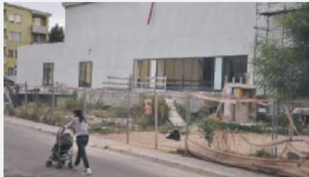
IL CANTIERE Lo stabile che dovrebbe ospitare la piscina di San Michele
